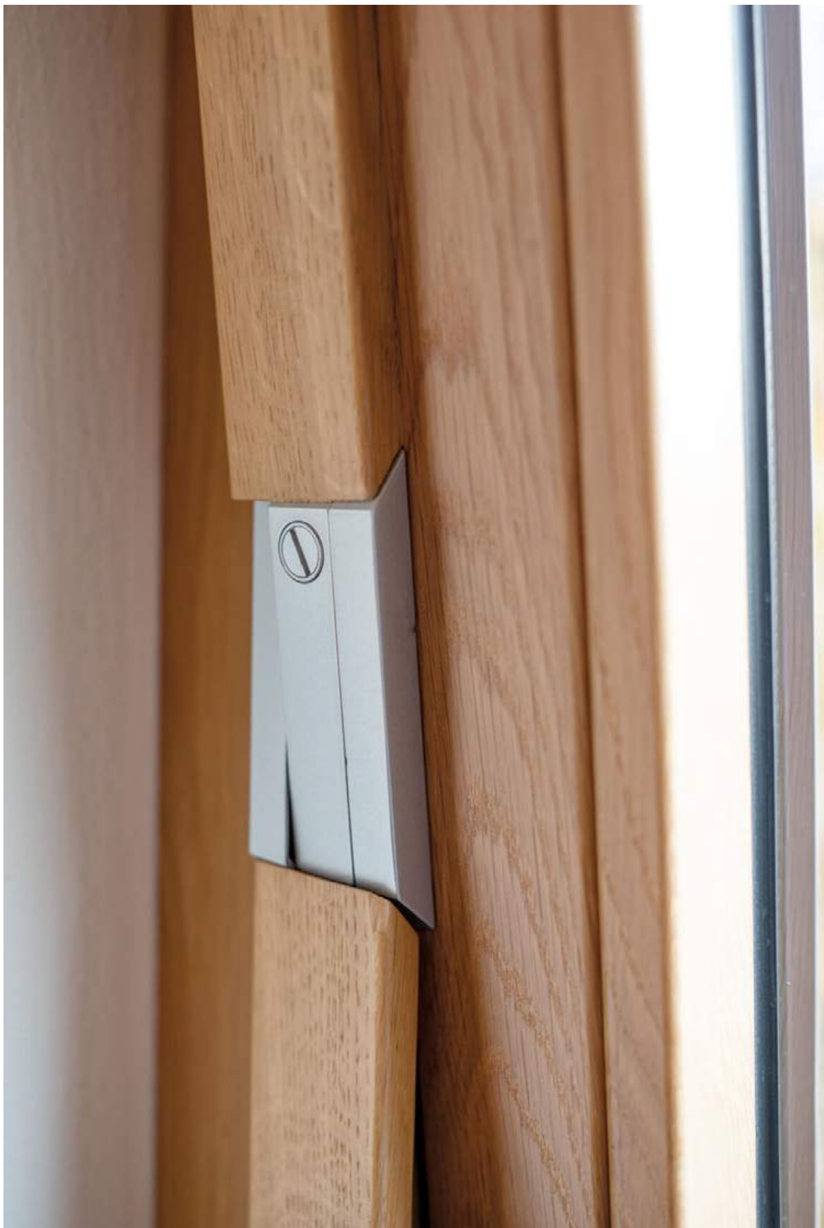
Dieser Beschlag ermöglicht das Schwingen des Flügels.
